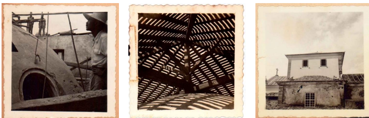
Figuras 14, 15 e 16. Nova Cúpula sendo construídas. Fotografia, 1953.
