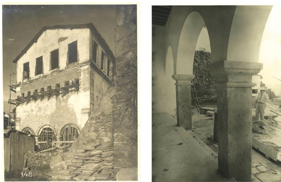
Figuras 27 e 28. Convento de Santa Teresa, fachada poente – reconstrução das arcadas de alvenaria. Fotografia, Jul. - Dez. 1958[?].
